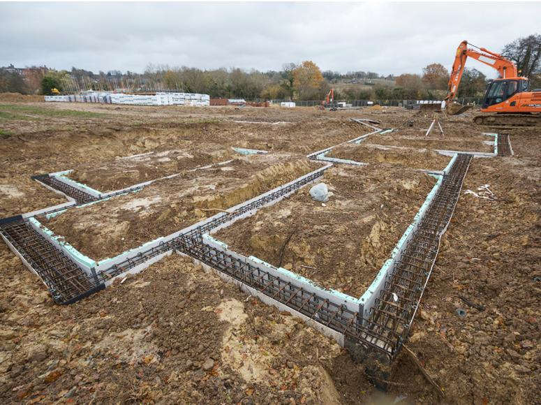
Heaveguard est un produit composé de polystyrène expansé compressible qui s'utilise lorsqu'il faut protéger des fondations contre le gonflement du sol. En tant que partie intégrante de la solution Cordek de protection contre le gonflement du sol, Heaveguard s'utilise pour assurer une protection contre les gonflements latéraux, de préférence au niveau de la face interne de longrines ou de semelle filante.
