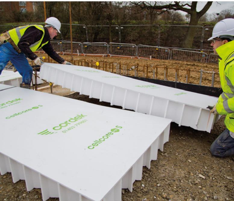
Cellcore HX est le dispositif déformable Cordek de quatrième génération de profilage du vide et, de par sa conception, il garantit une protection contre les effets du gonflement du sol.
