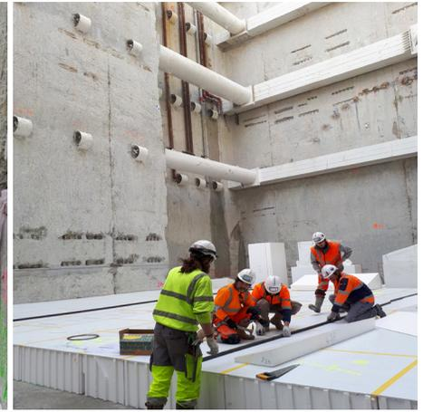
Ce dispositif de coffrage est donc constitué d'un unique niveau de panneaux Cellcore HG (alvéolé) sur lequel est superposé un étage de panneaux Filcor (EPS) à hauteur variable permettant d'ajuster le coffrage à la forme variable du « radier » .
